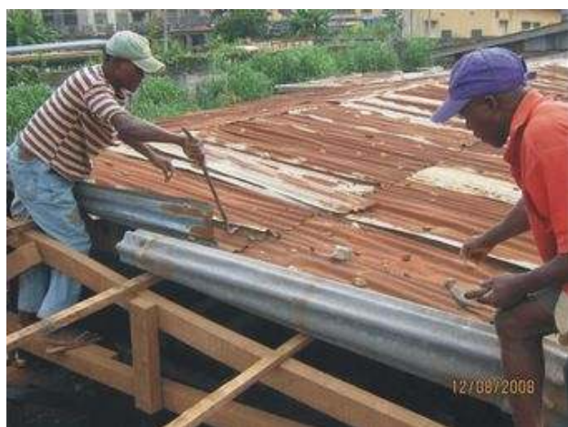
Das verrostete, undichte Dach wird entfernt
