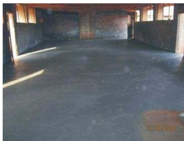
Neuer Fußboden in den Klassenzimmern
