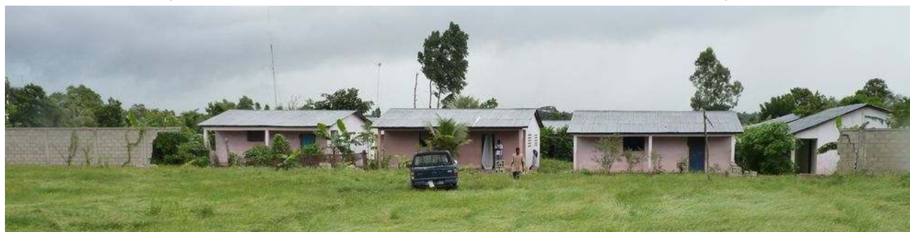
Blick von außen auf das Schulgelände. Die umgestürzte Mauer gibt nun den Blick auf die Gebäude frei.
