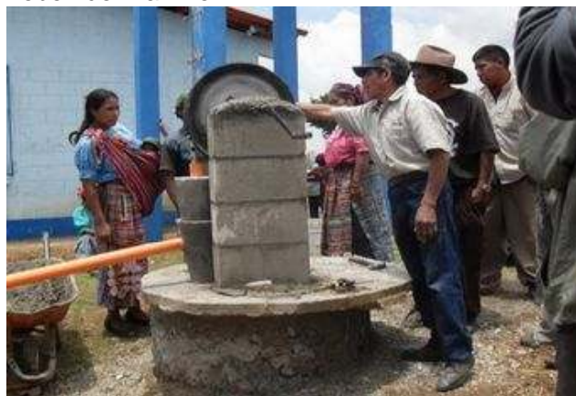
Installierung der Brunnenteile und Qualifizierung zur Nutzung und Wartung
