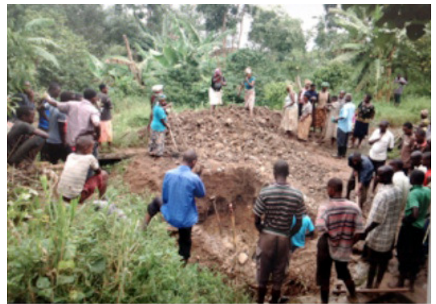
Die Gemeinde hilft mit bei der Aushebung
