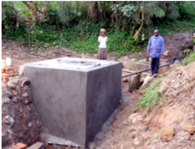
Das fertig gebaute neue Wassersystem
